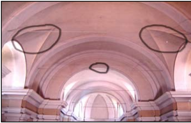
Sailletto - Chiesa di S.Leone: i danni alla volta
