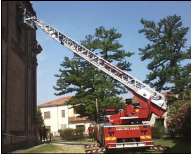
Controlli alla chiesa da parte dei Vigili del Fuoco
